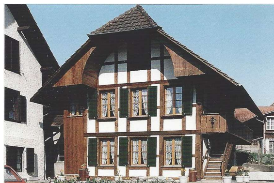
Der «Öli»-Stock erbaut 1853. An der selben Stelle stand bis zum Neubau des Stocks ein Speicher.
